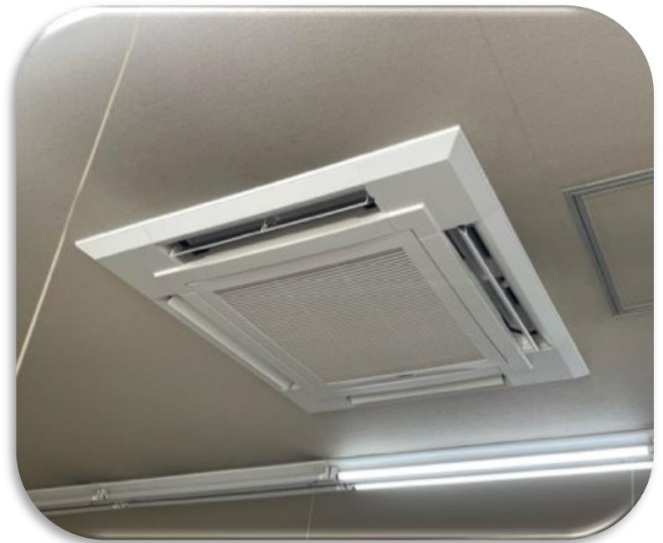
事務所1階・2階空調機入替 (室内機3台・室外機2台) 2024年7月19日実施
